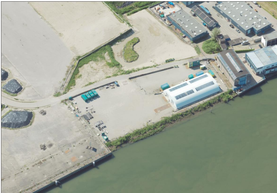
Figuur 8.3.2-1: Luchtfoto werkterrein, situatie 2021
